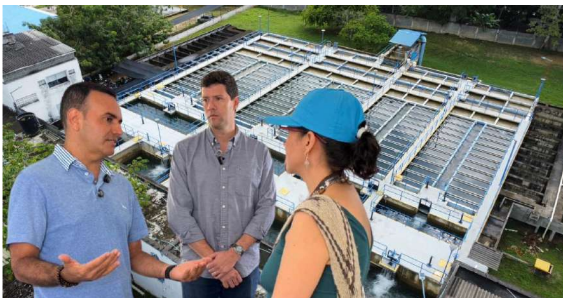
Imagen- Viceministra en La Planta de Tratamiento de Agua Potable (PTAP) de Cereté
